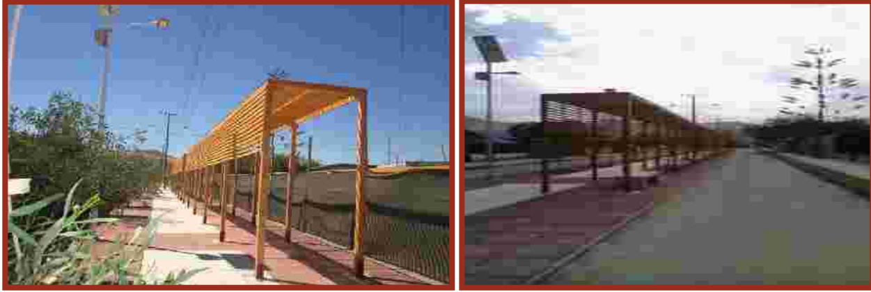
V.1. CONSTRUCCIÓN BANDEJÓN L. MUÑOZ DE G. VILLA 4 DE OCTUBRE.
