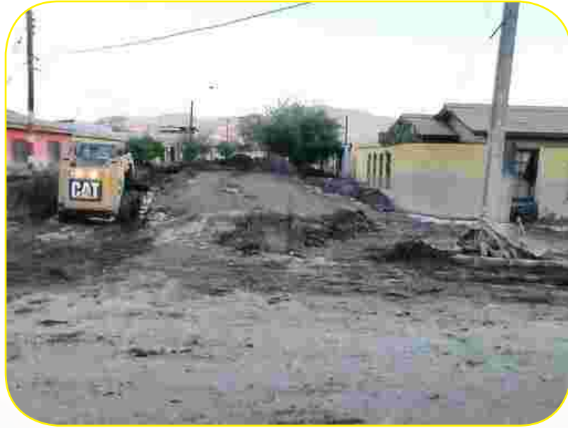
CALLES ANEGADAS CON BARRO Y LODO.
