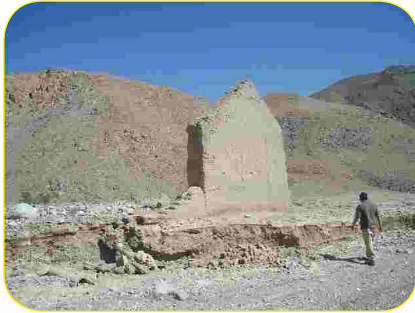
VISITA AL SECTOR DE LA FINCA DE CHAÑARAL CATASTRO DE DAÑOS
