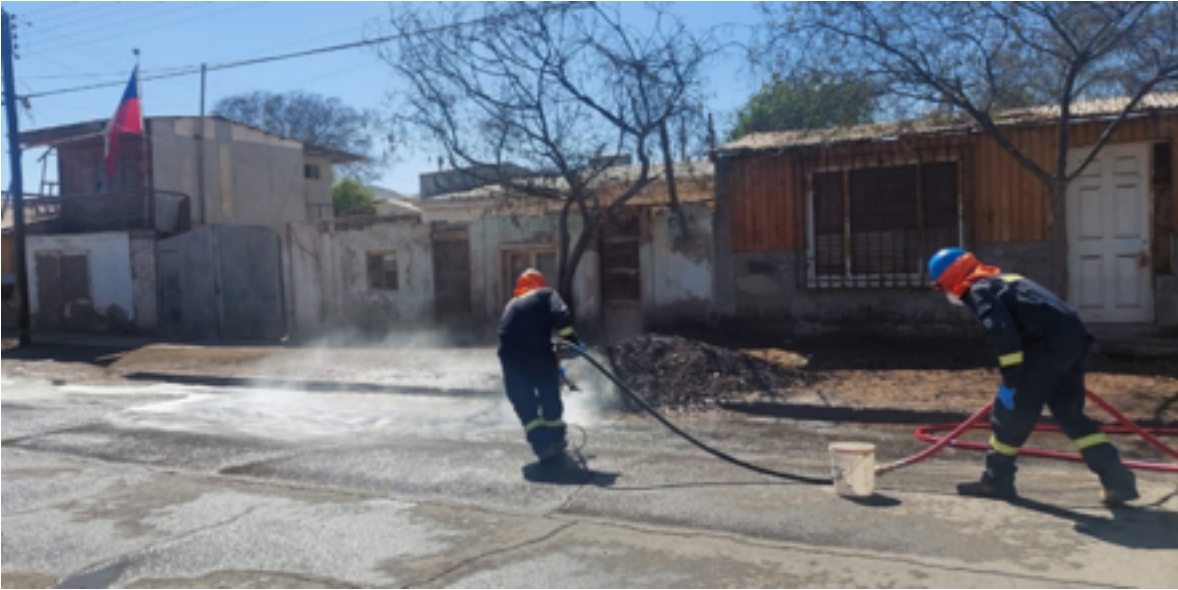
Derrame Petróleo Diésel - septiembre 2022
