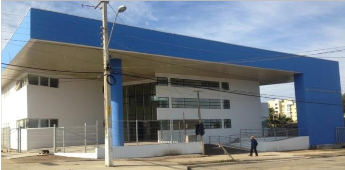
Fotografía N°2: El CESFAM de la comuna de El Tabo
