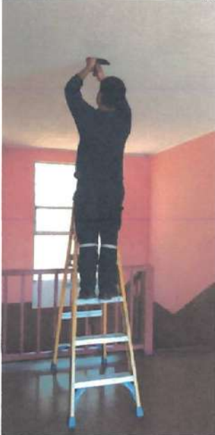
Reparación cielo caja escala
