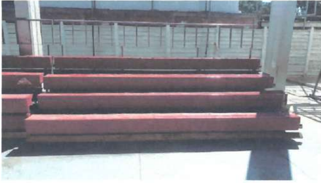
Reparación de galerías
