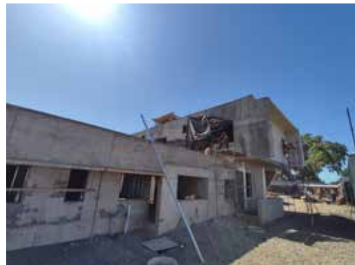
Construcción Cuartel Segunda Compañía de Bomberos Coihue, Comuna Negrete.
