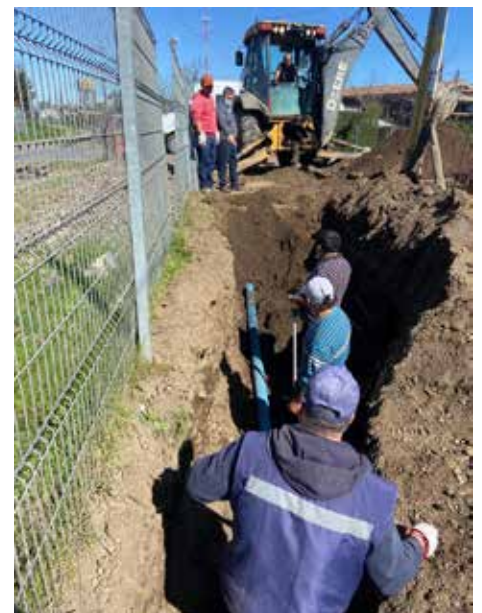
Funcionarios municipales en trabajos de conexión Extensión de Red El Sauce.
