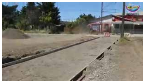
Pavimentación Lagos de Chile.
