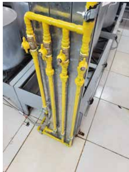
Normalización instalaciones de gas.
