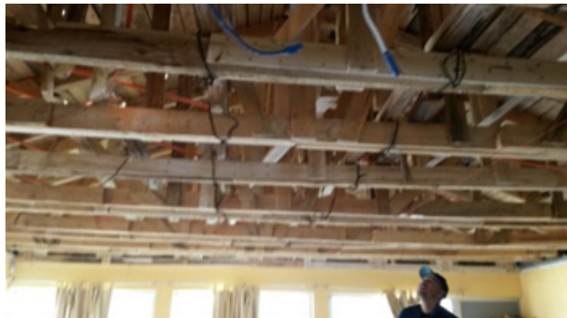
Refuerzo y reparación de estructura de Techumbre, Sala Cuna y jardín Infantil Semillita
