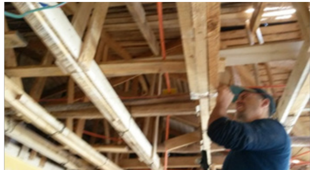
Refuerzo y reparación de estructura de Techumbre, Sala Cuna y jardín Infantil Semillita
