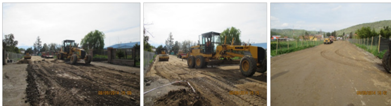
Imágenes trabajos calle Vicario Araneda.
