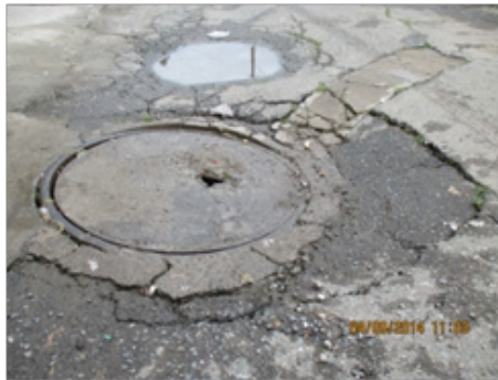
Imágenes Reposición de losa cámara de alcantarillado, Villa La Puntilla.
