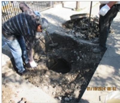
Imágenes Reposición de losa cámara de alcantarillado, Villa La Puntilla.
