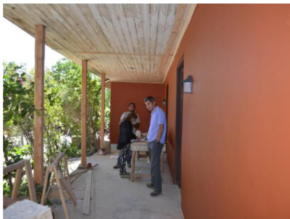
Proyecto FSV, Beneficiario Liliana Carreño, Proyectista ACZU, Constructora SyS Hermanos, Vivienda Ejecutada.
