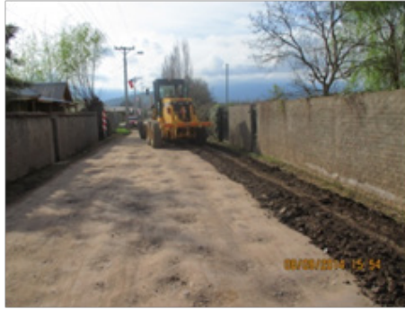
Imágenes trabajos Camino Tres Puentes.
