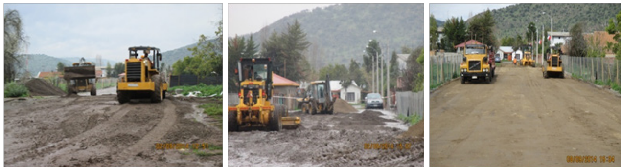
Imágenes trabajos calle Vicario Araneda.
