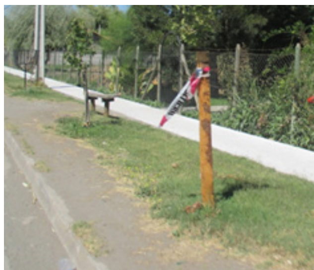
Obra Ejecutada: Reposición Veredas sector El Cardal
