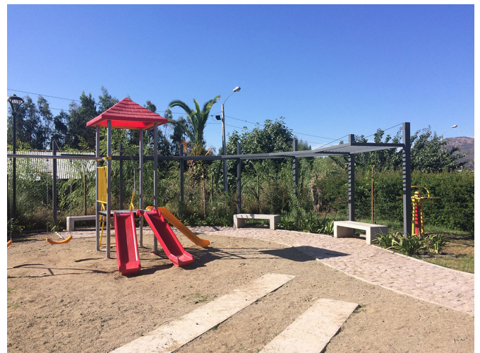
Construcción Área Verde y Mejoramiento Plazuela Villa Chillehue
