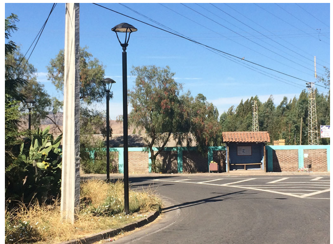
Iluminación Cruces de Coinco
