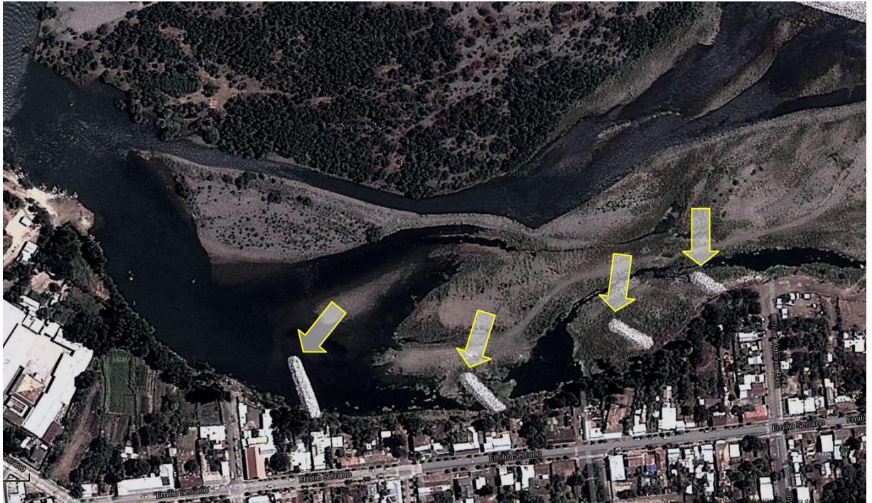
PUNTO CRÍTICO: APROXIMACIÓN DEL RÍO BIO BIO DIRECTAMENTE EN EL ÁREA URBANA. CAPILLA NUESTRA SRA. DEL CARMEN LICEO ENSEÑANZA BÁSICA. SE OBSERVAN ESPIGONES PROTECTORES CONSTRUIDO EN PROTECCION
